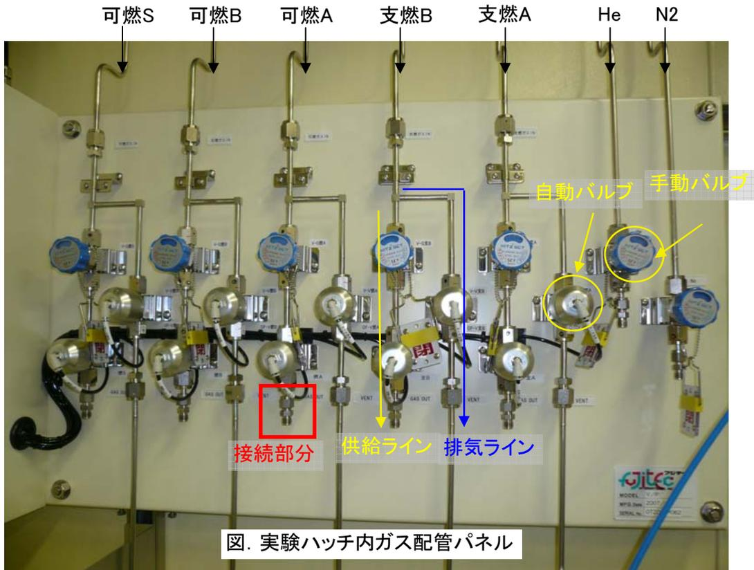
図. 実験ハッチ内ガス配管パネル
