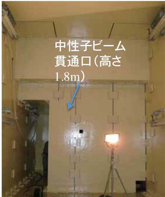
生体遮蔽体内(高さ約4.4m)
