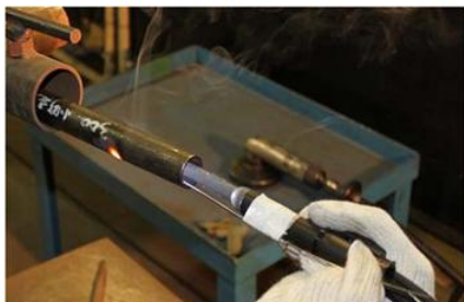
溶接の様子 <内径21.6(20A)> ⇒ 溶融池の確認不可
