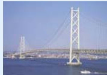
橋梁の主桁、橋脚、橋塔など
