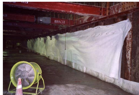
図2 地下施工現場
